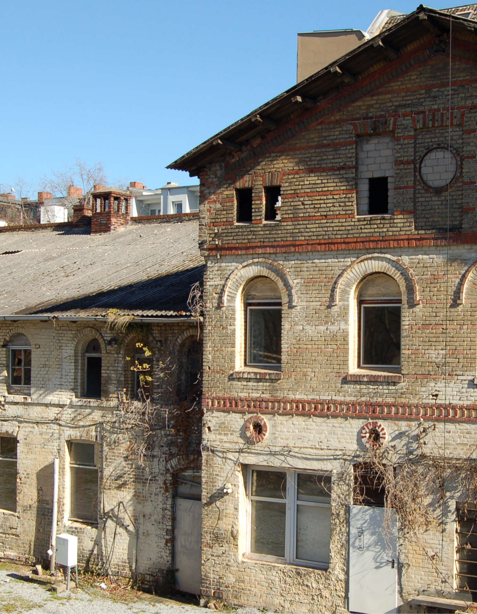
Abbildung 22: Remise in der Hochstraße 4 (2023)
