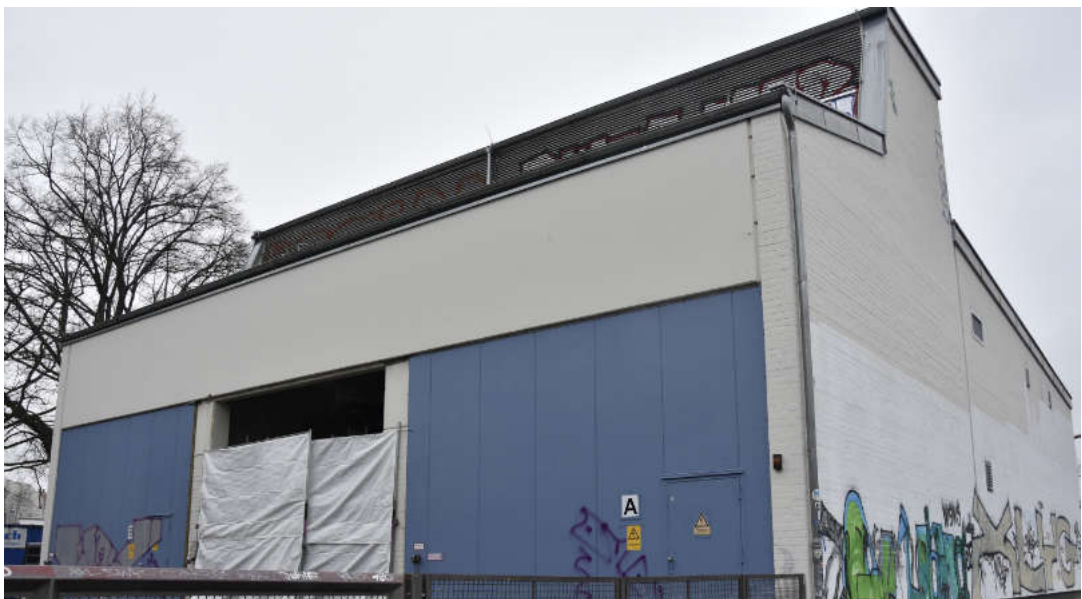
Abbildung 40: Umspannwerk Stromnetz Berlin, Böttgerstraße 29 (2023)
